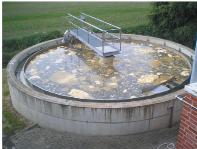
Abb. 2: Nachklärung bei Einleitung von fetthaltigen Abwasserinhaltsstoffen
