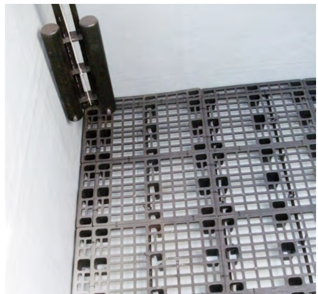
Abb. 3: Beispiel einer Kunststoffabdeckung am Boden einer Lösekommer. Links oben ist eine „schwimmende Entnahme“ zu sehen
