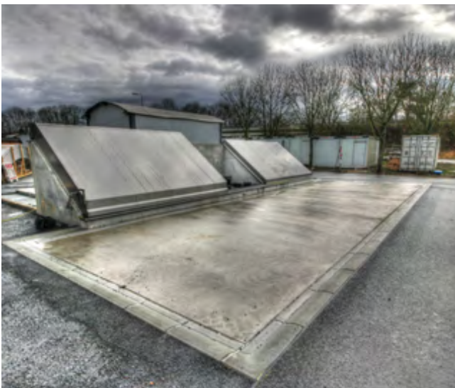
Abb. 2: Löse- und Dosierstation der Kläranlage Karlsruhe
