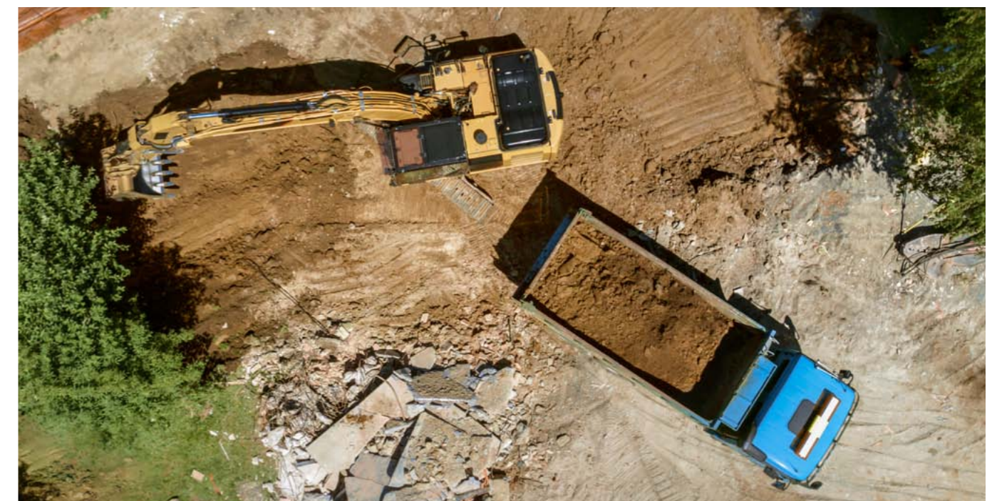
Abb. 3: Bodenentnahme im Rahmen einer Altlastensanierung
