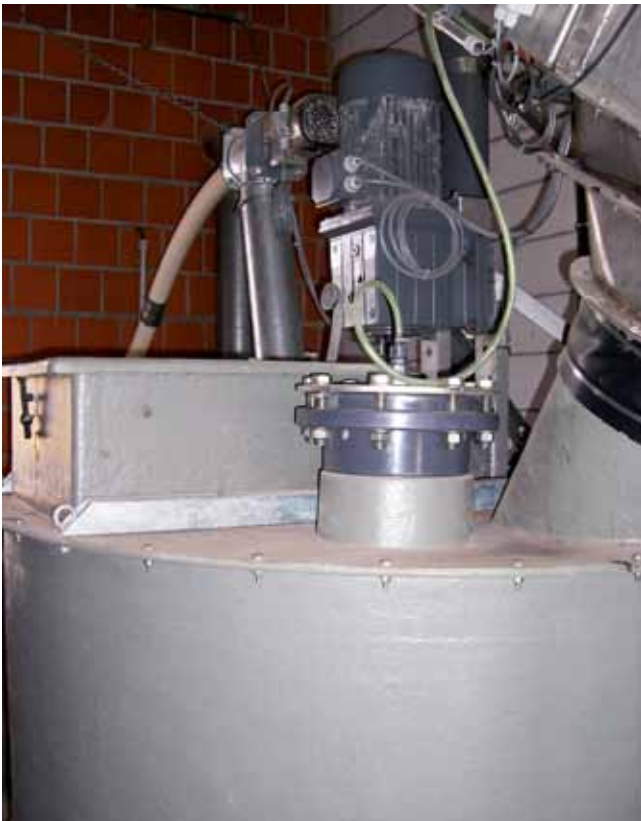
Abb. 2a und b: Mögliche Eisensalz-Dosierstellen, Anmischbehälter (links) und direkt in den Fermenter (rechts)
