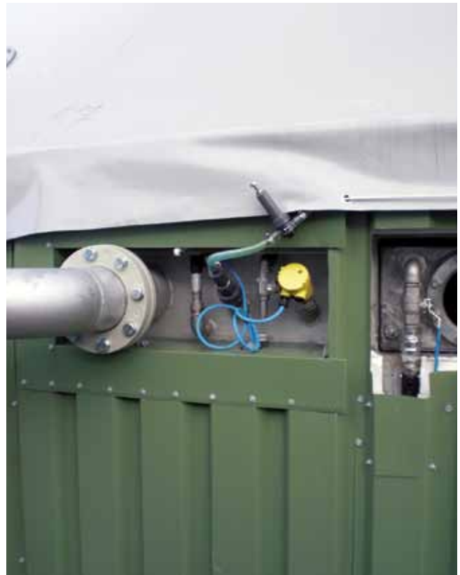
Abb. 2a und b: Mögliche Eisensalz-Dosierstellen, Anmischbehälter (links) und direkt in den Fermenter (rechts)
