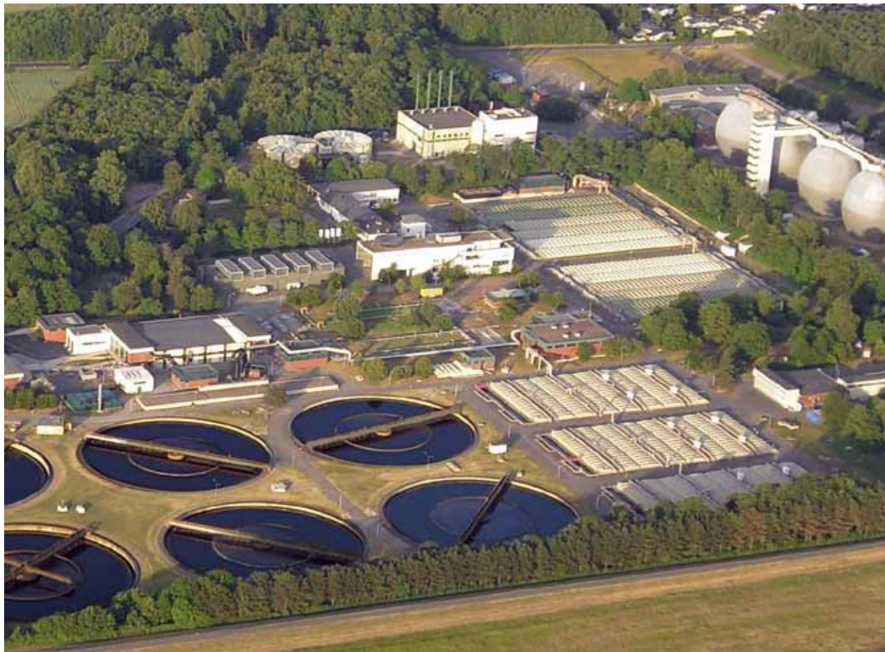
Figure 1 : Grande station d'épuration de Köln-Stammheim
