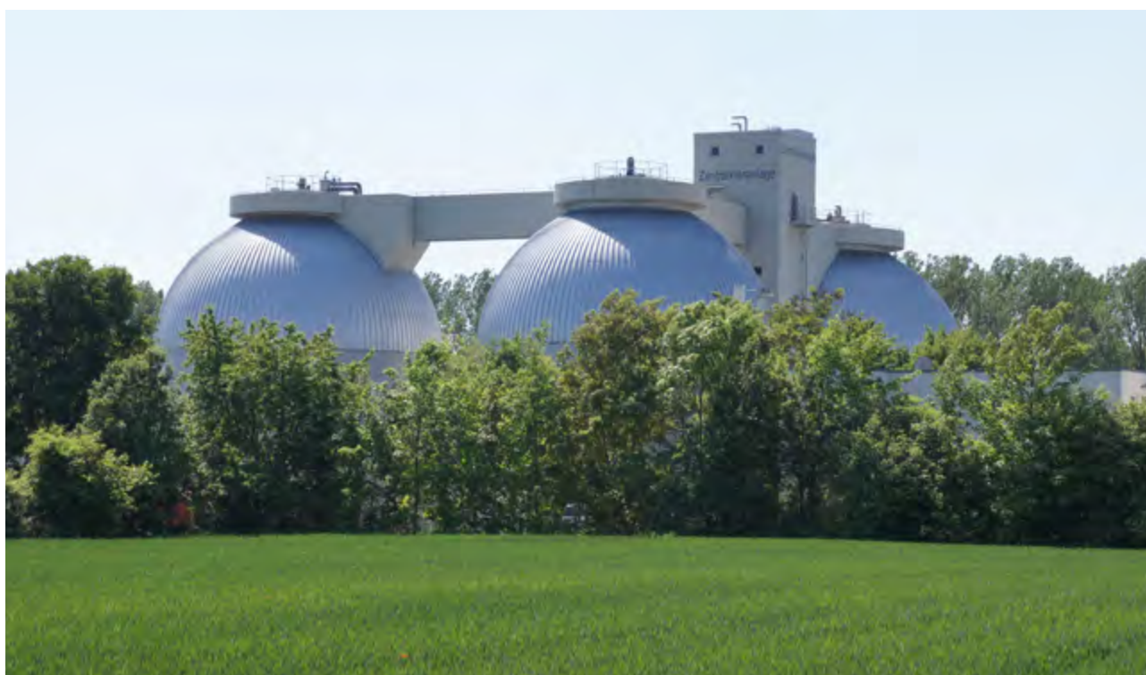
Abb. 1: Faultürme Kläranlage Ingolstadt
