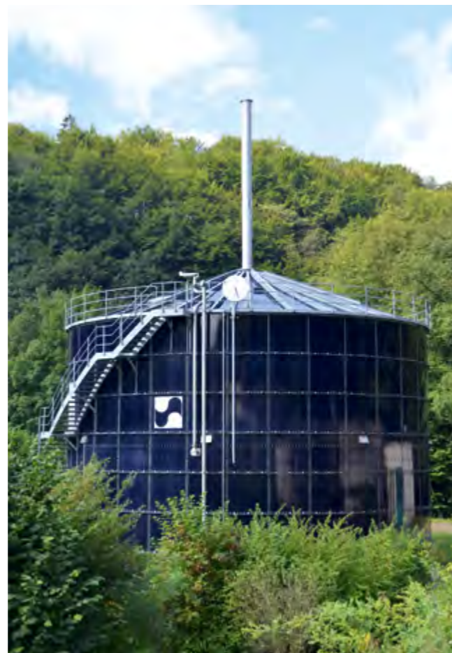
Abb. 3: Gasometer Kläranlage Solingen-Burg
