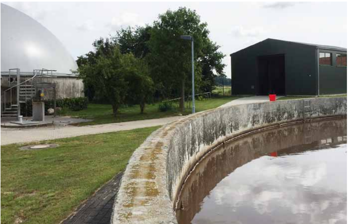
Abb. 12: Direkte Nachbarschaft: Der Schlamm aus der Flotationshalle wird energetisch genutzt.
