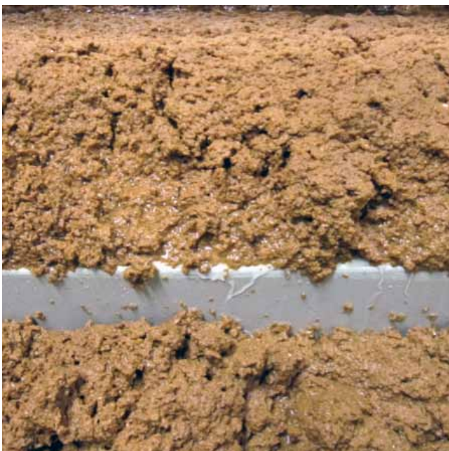
Abb.10: Flotatschlamm wird mittels Skimmer ausgetragen
