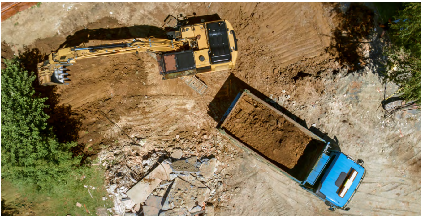
Abb. 3: Bodenentnahme im Rahmen einer Altlastensanierung
