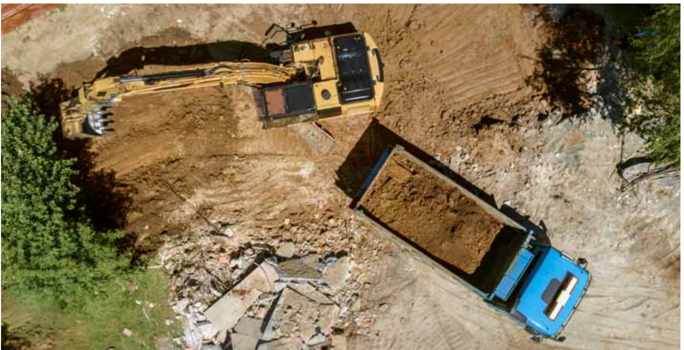
Abb. 3: Bodenentnahme im Rahmen einer Altlastensanierung
