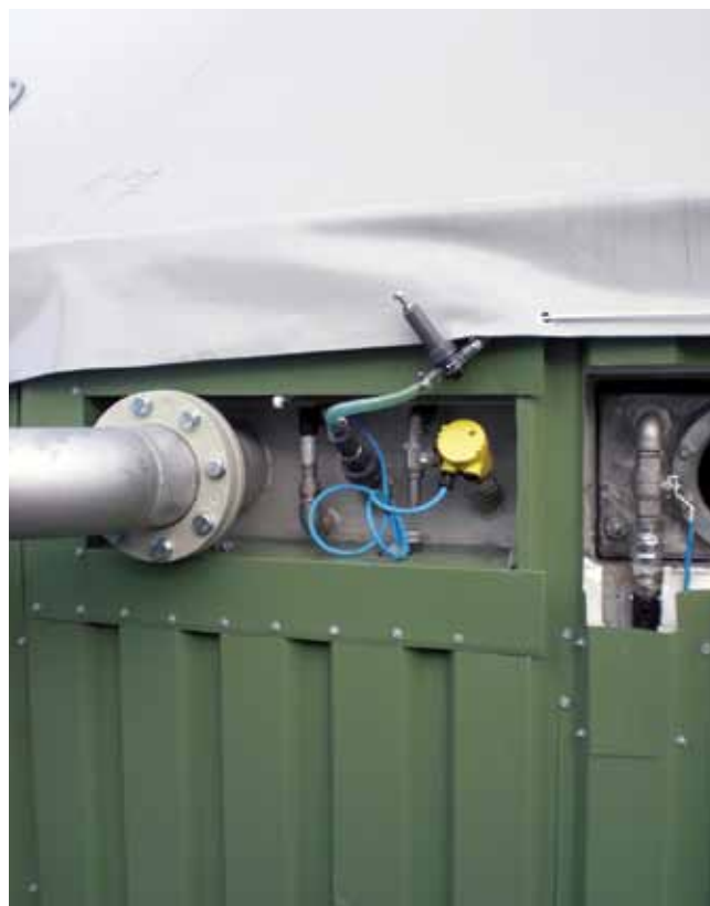
Fig. 2a et b : points de dosage de sel de fer possibles, dans la cuve mélangeuse (à gauche) et directement dans le fermenteur (à droite)
