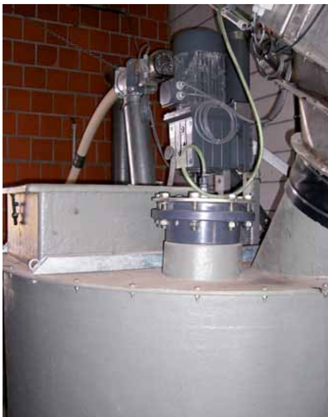
Fig. 2a et b : points de dosage de sel de fer possibles, dans la cuve mélangeuse (à gauche) et directement dans le fermenteur (à droite)
